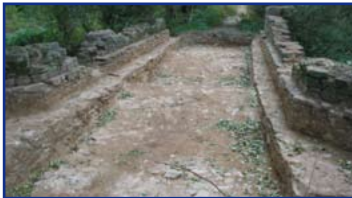
Odkrytá část mostovky v říjnu 2008
