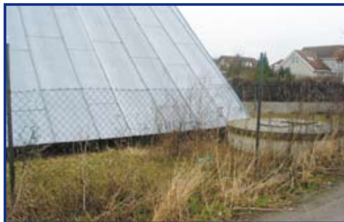
Pozemek u bývalé ČOV u Horoušánek
