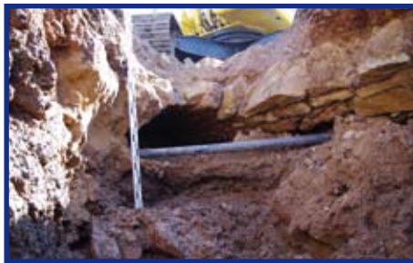
Výkop s nalezenými zbytky konstrukce kanálu
