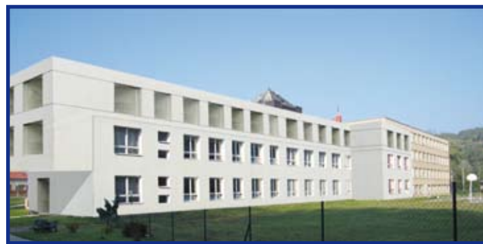
Budovy základní školy se zakreslenou nástavbou 2. nadzemního podlaží
