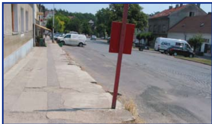
Chodník před zahájením opravy
