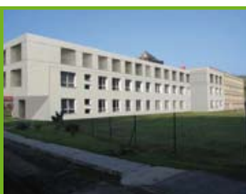
Nástavba Základní školy Úvaly, str.8
