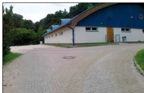
Čistírna odpadních vod, str. 4
