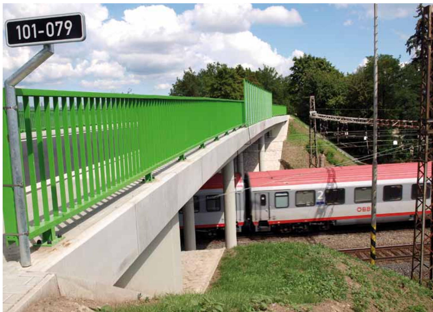
Rekonstruovaný most dokončen – foto Jan Poledník
