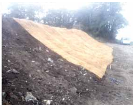
Opevnění svahu Na Vinici
