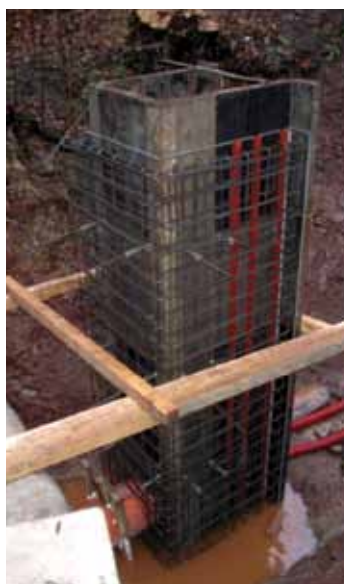
Spodní výpust Jam během stavby
