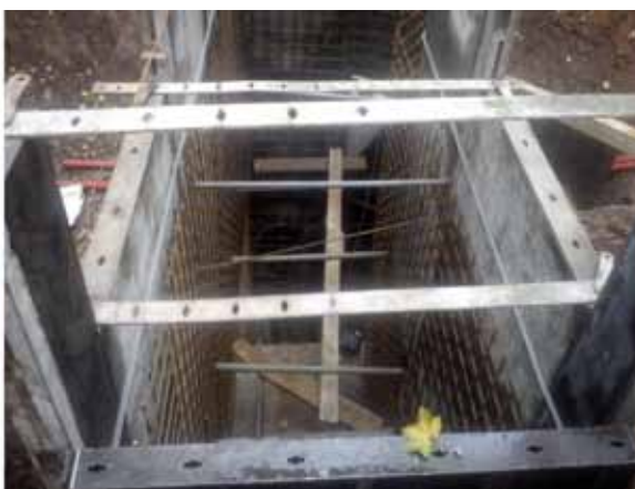
Jámy – Bezpečnostní přeliv – vlevo - vybudovaný a vpravo - během stavby
