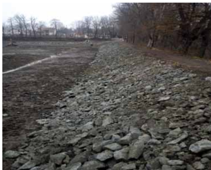
Opevnění hráze Fabráku
