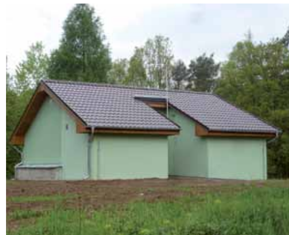
Vodjem Rohožník po rekonstrukci
