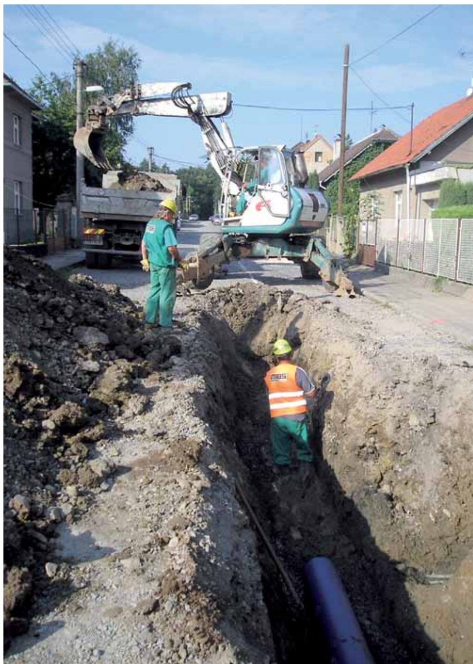
Rekonstrukce vodovodního řadu v ulici Otokara Březiny,
