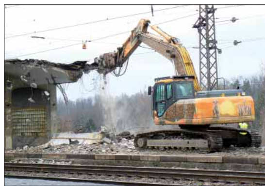
Bourání zastřešení z monolitického betonu 2. nástupišť dne 19. 3. 2014, foto Vladislav Procházka
