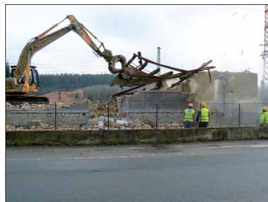
Demoliční práce na budově skladů dne 25. 3. 2014, foto Vladislav Procházka
