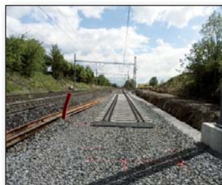
Modernizace trati, str. 9
