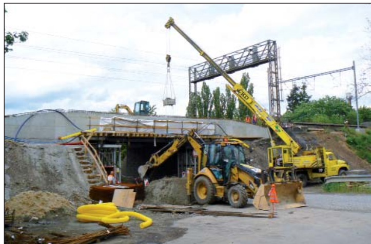
Práce na mostním objektu ve Škvorecké ulici, foto Vladislav Procházka
