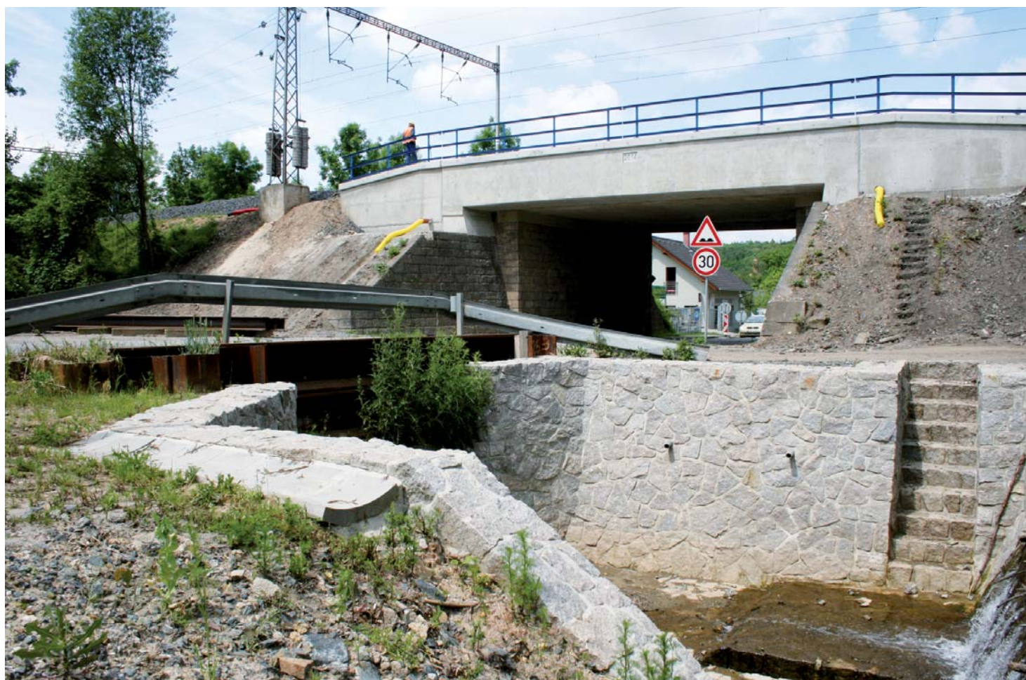
Rozšíření železničního mostu a průjezdu ve Škvorecké ulici – foto Václav Vícovský
