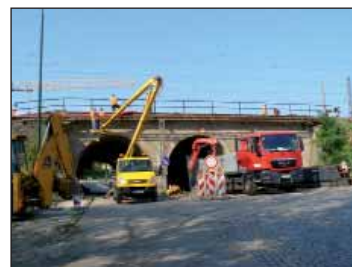
Zahájení rekonstrukce mostu v ulici Na Spojce – foto Vladislav Procházka
