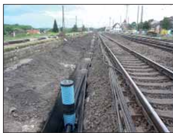
Montáž odvodnění
