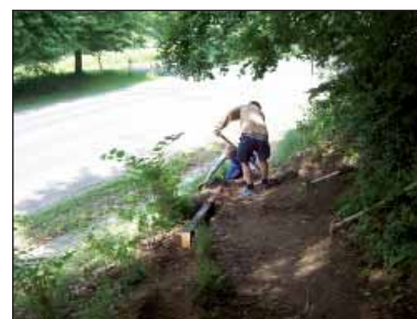
Zpevnění svahu u vyústění na silnici č. I/12 směrem do ulice Osadní
