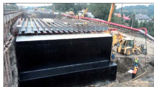
Výstavba mostu Na Spoje
