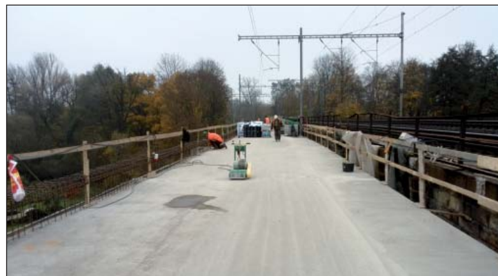
Nová nosná deska mostu „Výmola“
