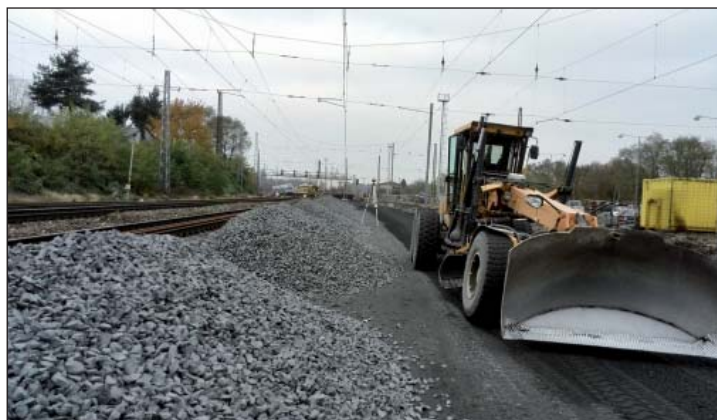
Zřizování konstrukčních vrstev kolejí na „pražské straně“
