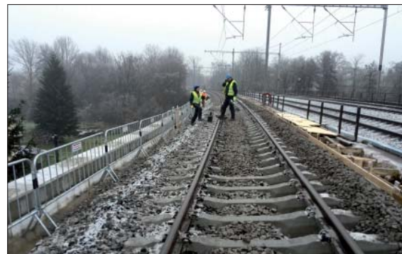
Rekonstrukce mostu Výmola
