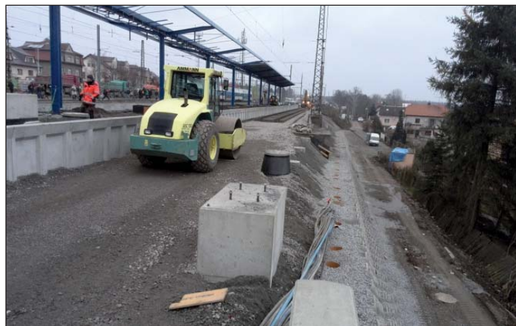
Práce na montáži koleje č. 4. V pozadí „roste“ konstrukce zastřešení, vpravo je vidět nová opěrná zeď a přístupový chodník z prodlouženého podchodu do ulice Pod Trať.
