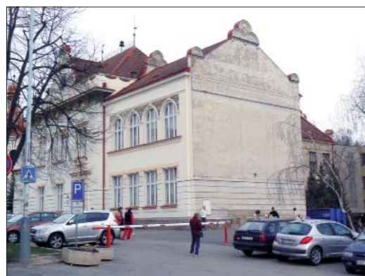
Velká prázdná plocha jižní fasády budovy základní školy upoutává zájemce o street art
