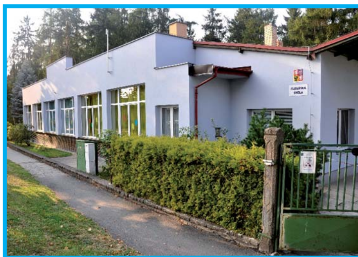
Budova MŠ Pražská
