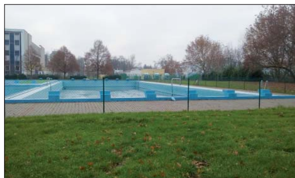
Velký bazén koupaliště – v popředí vidět oddělovací plot a v pozadí 3 filtry
