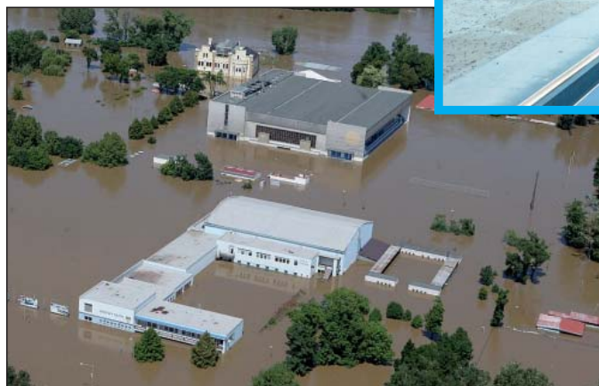
Koupaliště při povodni v roce 2013 – plocha úplně vlevo nahoře, z vody kouká pouze skluzavka
